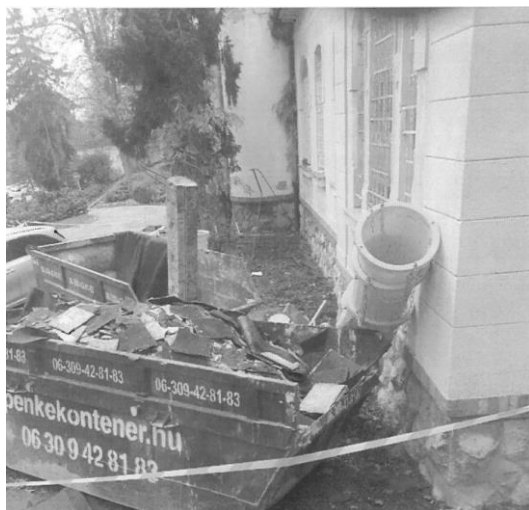
A leszakadt ledobó-cső és a leszakadt korlát a talajszintről nézve (munkavédelmi hatóság felvétele)
