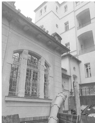
A leszakadt ledobó-cső és a leszakadt korlát a talajszintről nézve (munkavédelmi hatóság felvétele)
