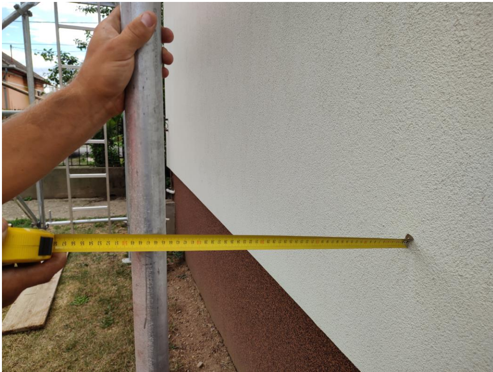
Az építési állvány és az épület homlokzata közötti 0,40 m távolság (munkavédelmi hatóság felvétele)
