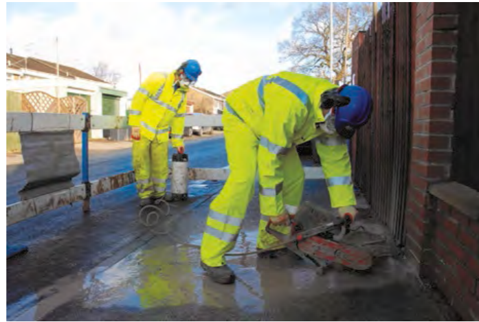
1. ábra: Vízpermetező rendszerrel rendelkező betonvágó Forrás: Health and Safety Executive, Nagy-Britannia (a továbbiakban: HSE)
