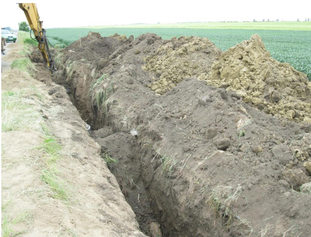
A dúcolatlan függőleges földfalú munkaárok géppel történő visszatöltése (munkavédelmi hatóság felvétele)
