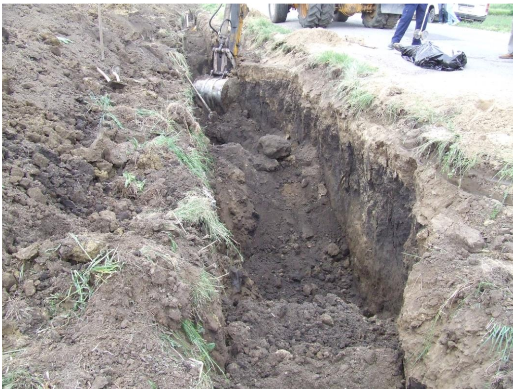
A beomlott dúcolatlan függőleges földfalú munkaárok és a munkagödörből kiemelt elhunyt munkavállaló (munkavédelmi hatóság felvétele)
