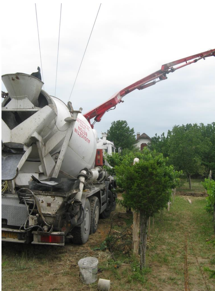
Betonszivattyú és mixerkocsi a 20 kV feszültségű villamos vezeték alatt (munkavédelmi hatóság felvétele)
