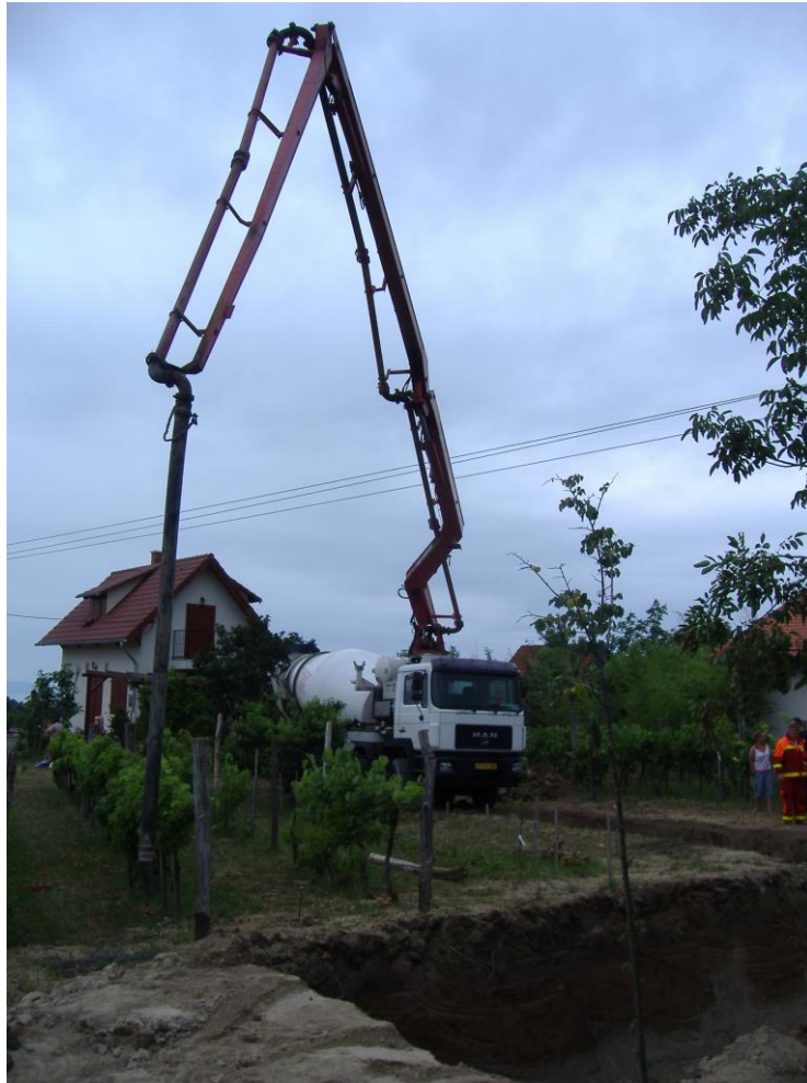
Betonszivattyú gémje a 20 kV feszültségű villamos vezetéket veszélyesen megközelítette (munkavédelmi hatóság felvétele)
