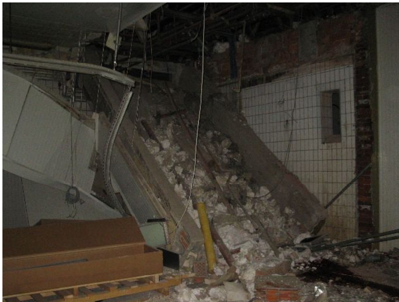
A leszakadt födém a baleset helyszínén (munkavédelmi hatóság felvétele)
