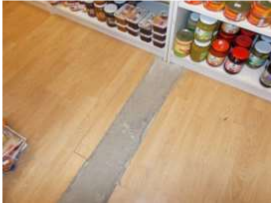
Raktár bejáratánál a hiányos, botlásveszélyes padlóburkolat.
