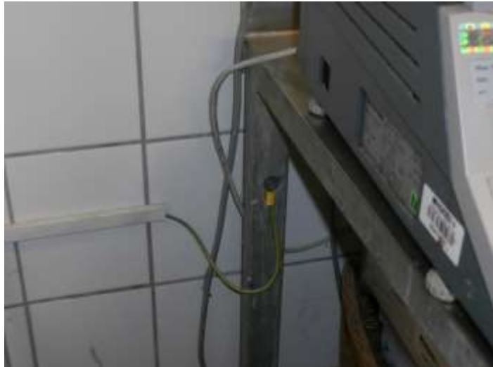
Az egyenpotenciálra hozó hálózathoz csatlakoztatott fém előkészítő asztal.
