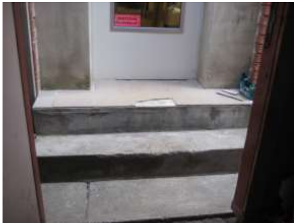
Raktár bejáratánál a hiányos, botlásveszélyes padlóburkolat.
