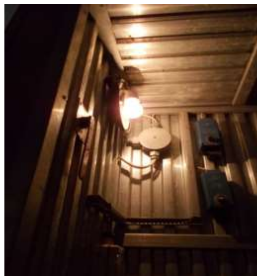
Tároló belső világításnál lámpatest IP védettsége nem megfelelő.
