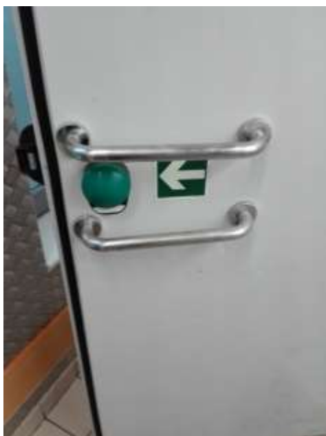
Fagyasztó helyiség nyitószervezete és jelölése.
