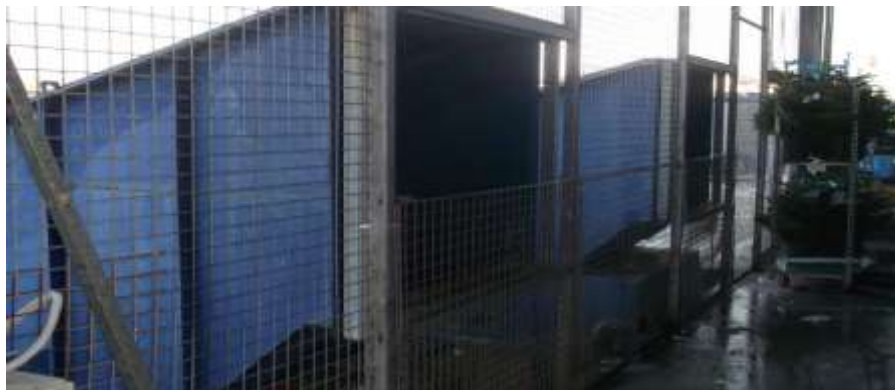
Beesést megakadályozó rács telepítése a hulladéktömörítő berendezések elé.
