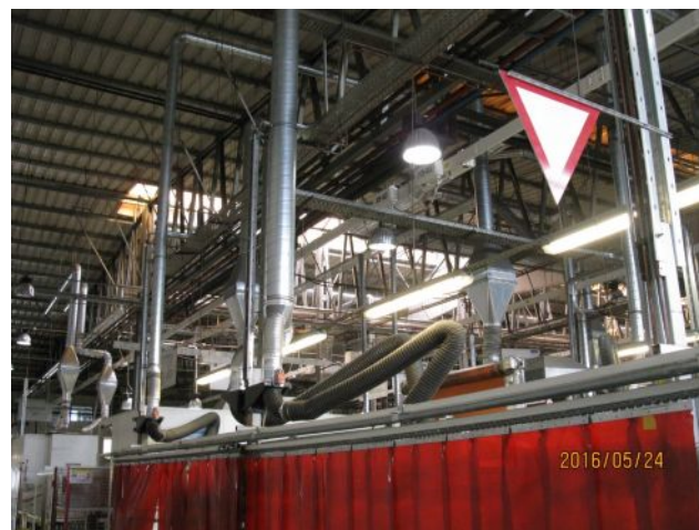
„Hagyományos” hegesztő munkahelyen és hegesztőrobotoknál kialakított elszívó rendszer
