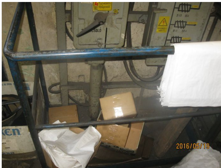
A 400 V-os villamos kapcsolószekrény alatt éghető anyagú kartonpapír dobozok, amelyek rövidzárlat esetén a szikraképződés során könnyen lángra kaphatnak
